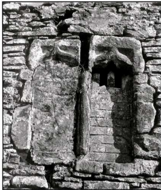
Ffenestr garreg fyllinog o'r Oesoedd Canol a ddaeth i'r amlwg o dan haenau o wyngalch a rendr yn ystod y broses o ddatymalu'r eglwys Stone mullioned medieval window uncovered from beneath layers of lime wash and render during the dismantling process
