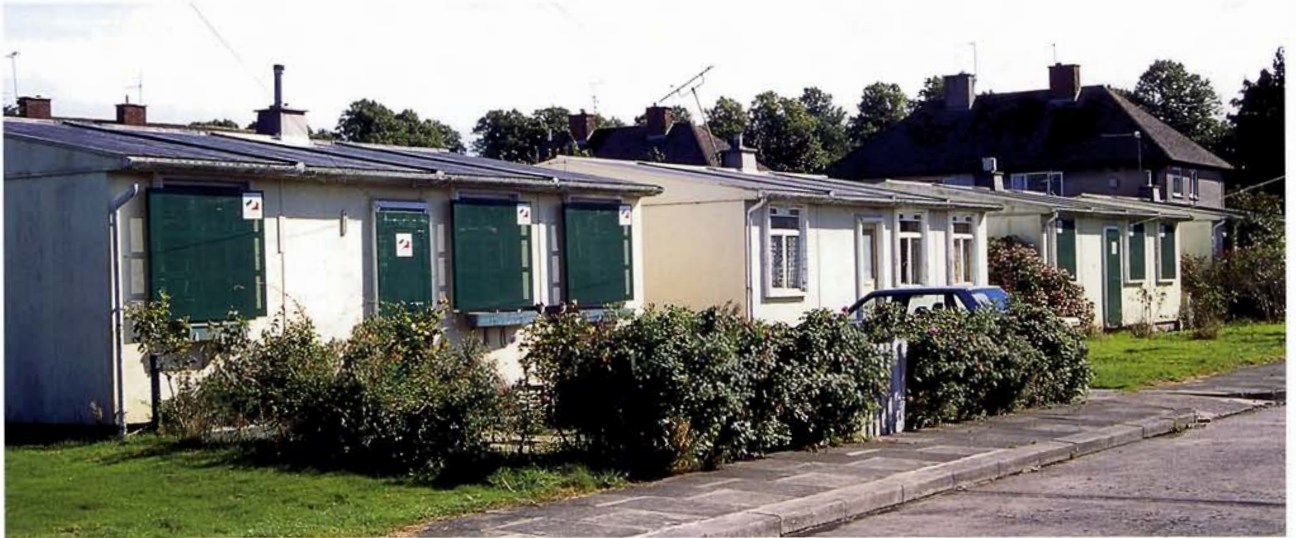
Rhai o'r prefabs gwag yng Nghilgant Llandinam, yn disgwyl cael eu dymchwel. Some of the vacant prefabs at Llandinam Crescent, waiting to be demolished.
